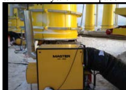
Строительные площадки со сложными условиями работы
